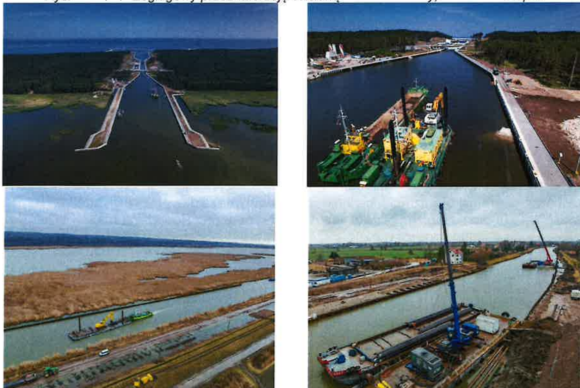
Rys. 4. Kanał Żeglugowy przez Mierzęję Wiślaną – stan aktualny, budowa II etapu.
